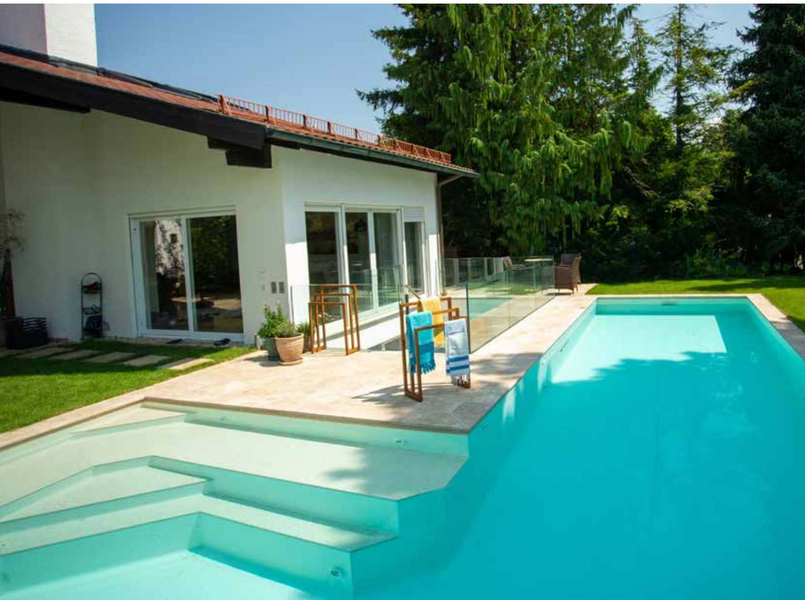
Im kurzen Teil des Beckens wurde eine Treppenanlage mit Sitz- und Liegebereich eingebaut, in dem Massagedüsen integriert sind.
