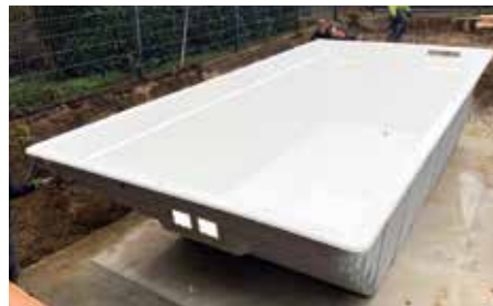
Das Becken wurde in einem Stück im Werk produziert, mit einem Lkw zur Baustelle transportiert, wo es ein Kran in die vorbereitete Baugrube hob.
