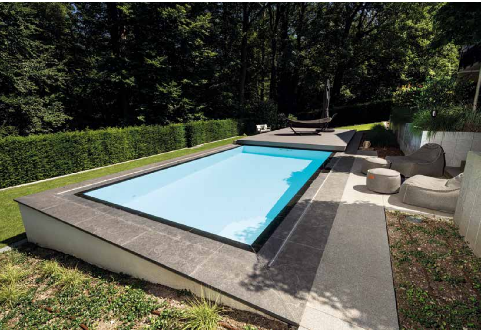
Das Polystone-Überlaufrinnenbecken hatten die Bauherren in der Ausstellung von Schwimmbad-Henne gesehen und waren begeistert.
