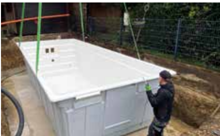
Das Becken wurde in einem Stück im Werk produziert, mit einem Lkw zur Baustelle transportiert, wo es ein Kran in die vorbereitete Baugrube hob.
