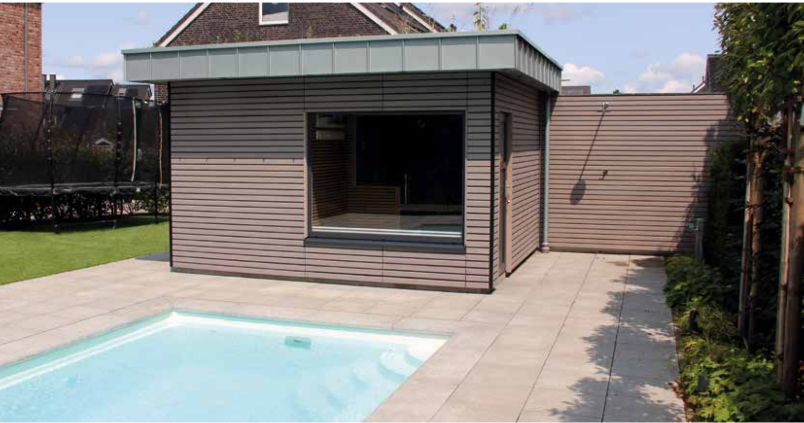
Das Saunahaus wurde konventionell errichtet und in den bestehenden Raum baute Swim & Sweat die Saunakabine ein.
