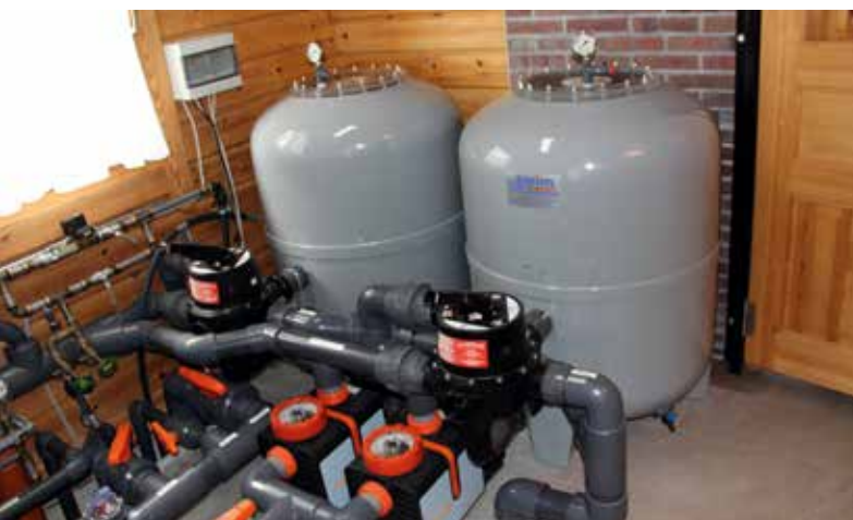
De sopra-zwembadtechniek is ondergebracht in een tuinhuisje. Twee filtersystemen met pompen en het meet- en regelsysteem "sopra test premium 17" zijn hier aan het werk.
