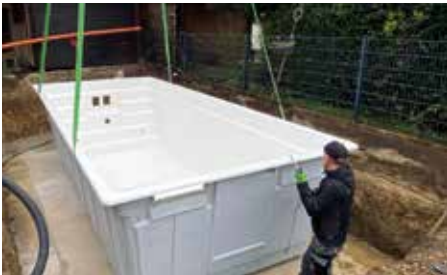
Het bassin werd in de fabriek uit één stuk gemaakt en per vrachtwagen naar de bouwplaats vervoerd. Daar tilde een kraan het bassin in de voorbereide bouwput.
