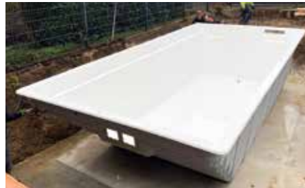
Het bassin werd in de fabriek uit één stuk gemaakt en per vrachtwagen naar de bouwplaats vervoerd. Daar tilde een kraan het bassin in de voorbereide bouwput.
