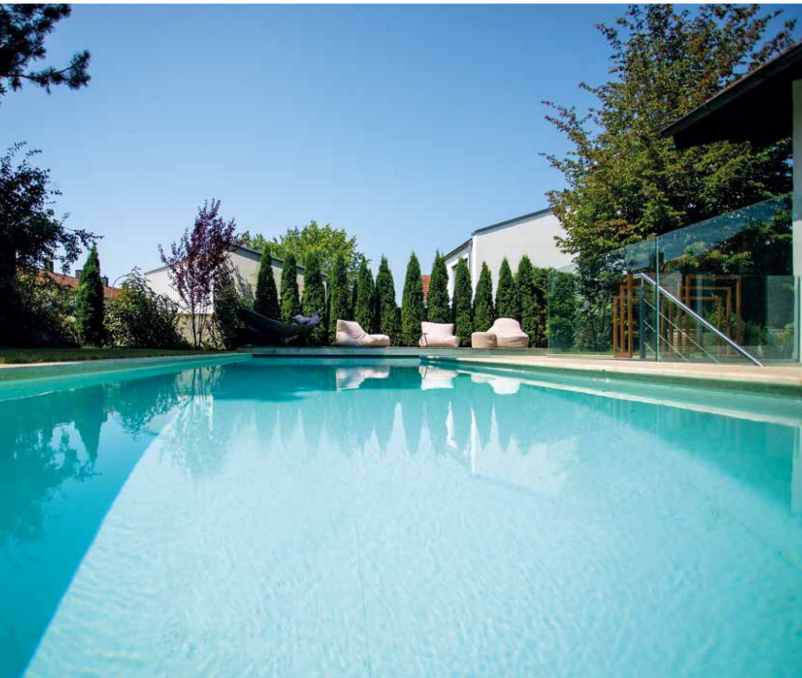
Boven de kast voor de lamellenafdekking is een houten dek gebouwd, dat gebruikt kan worden als lig- en zonneterras.
