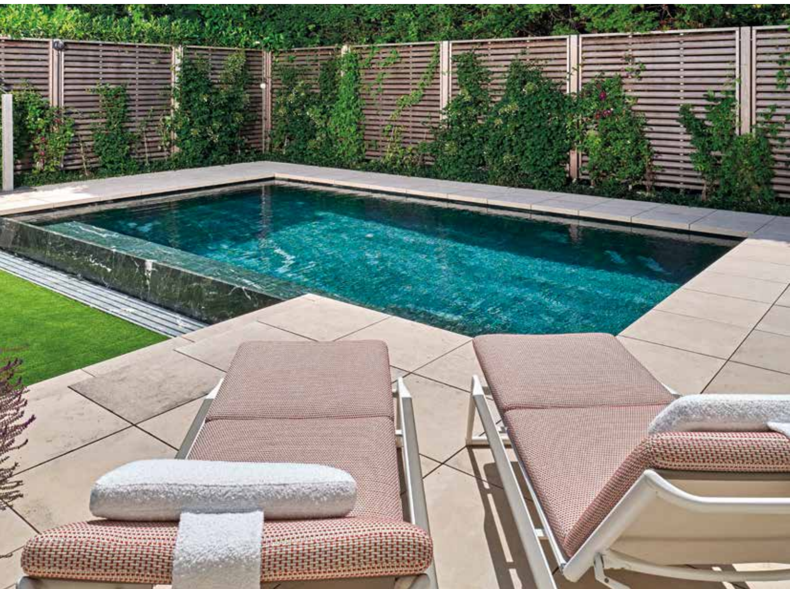
Het water stroomt via een overlooprand ongeveer 50 cm diep in een verborgen opvanggoot. Daardoor bestaat er vanuit het zwembad vrij zicht op de tuin.
