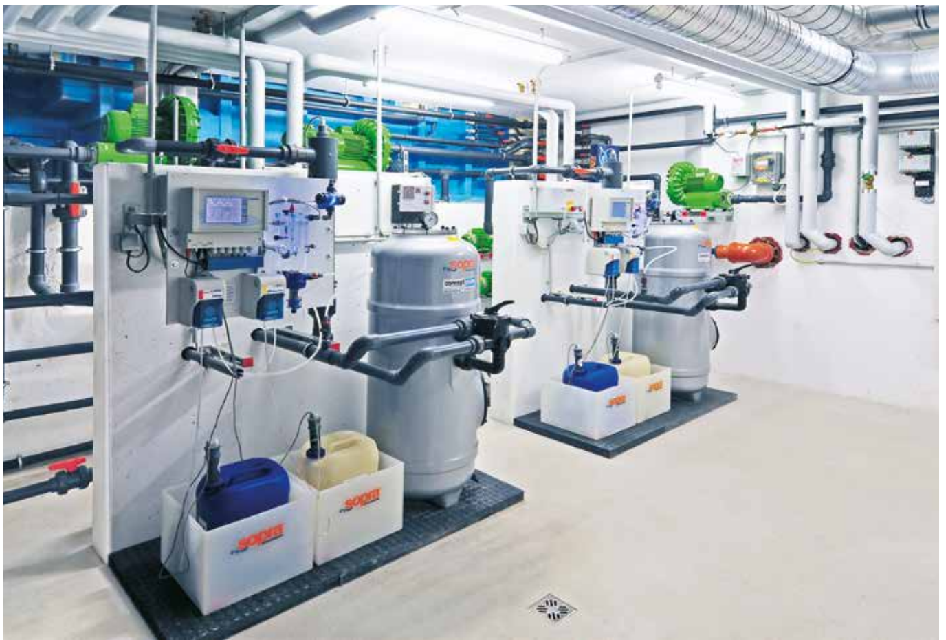
De zwembadfaciliteit is volledig onderkelderd. Zodoende is er veel ruimte voor de zwembadtechniek. Gerealiseerd door sopra Salzburg
