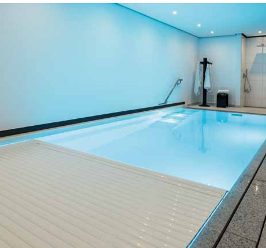
De overloopgoot is bedekt met natuursteen en ook een afdekking maakt deel uit van het geheel.
