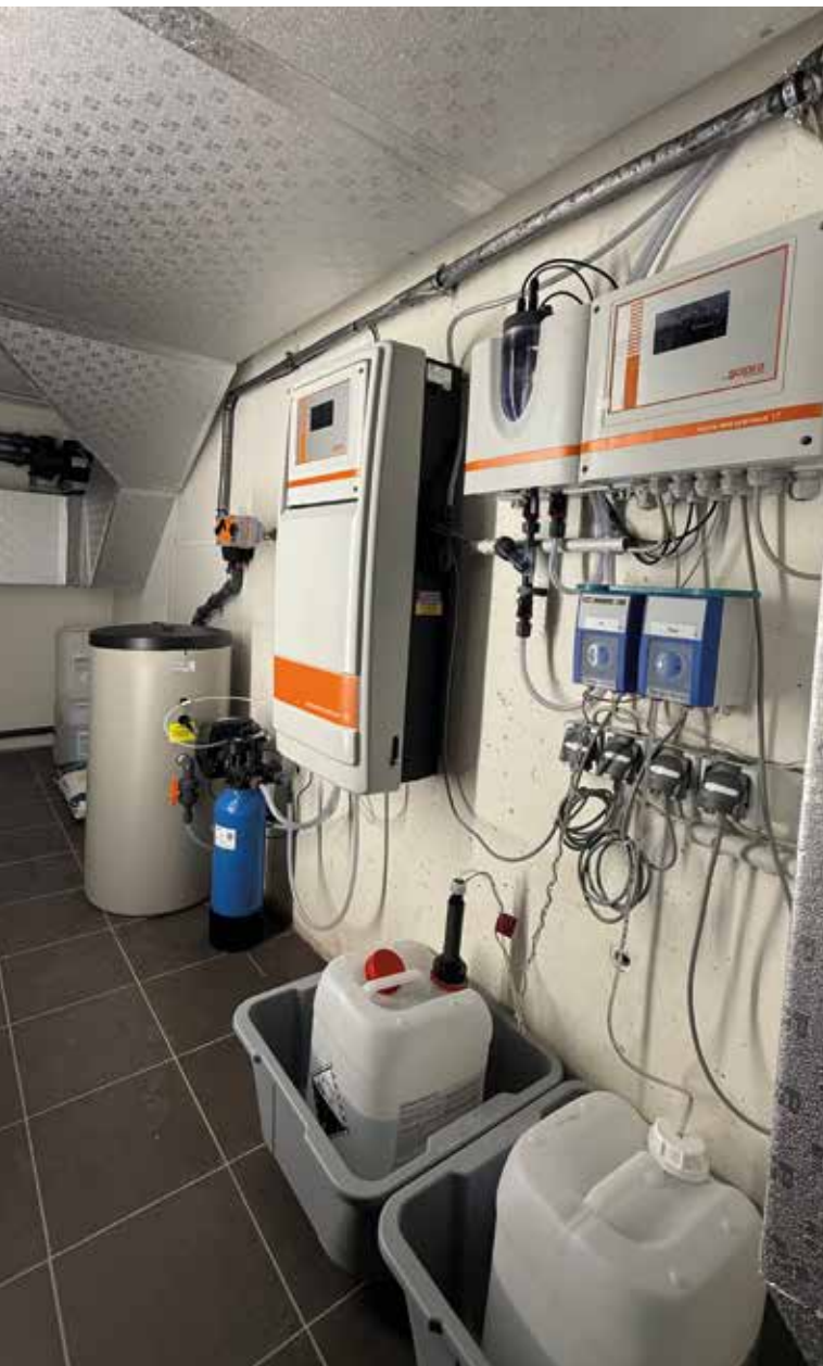
De sopra-zwembadtechniek in de kelder met "sopra test premium 17" en "soprazon premium 19" (links), het sopra-filtersysteem (boven) en het ventilatie- en ontvochtigingsapparaat.
