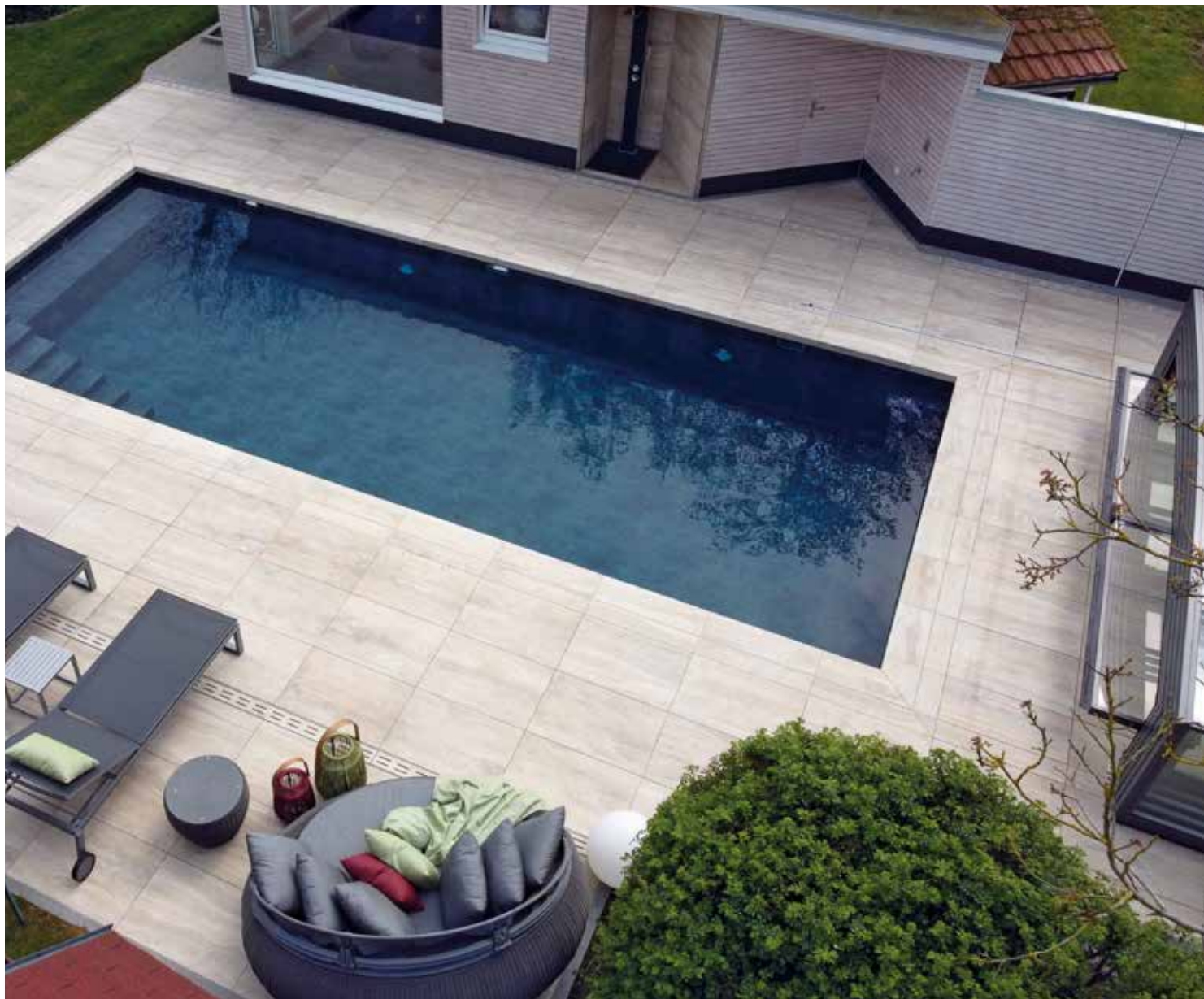
De opdrachtgever koos voor een skimmerbassin van ter plaatse gestort beton met foliebekleding en een aflopende bassindiepte. Een toegangstrap en een zitbank behoren eveneens tot de uitrusting.
