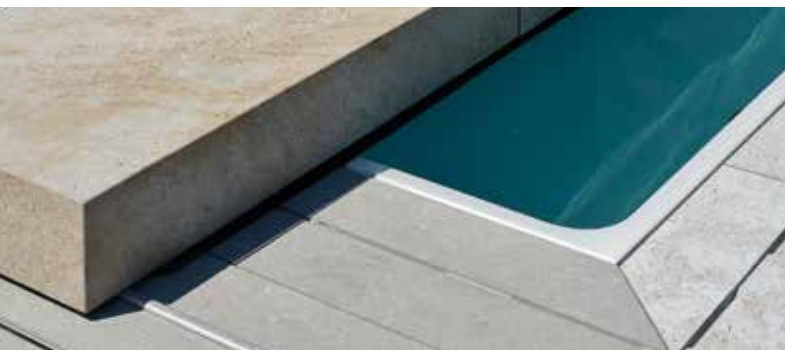
Een van de blikvangers van dit zwembad is het met natuursteen beklede schuifdek. Het is handmatig te bedienen, schuift onder de stenen bank weg en sluit het zwembad veilig af.
