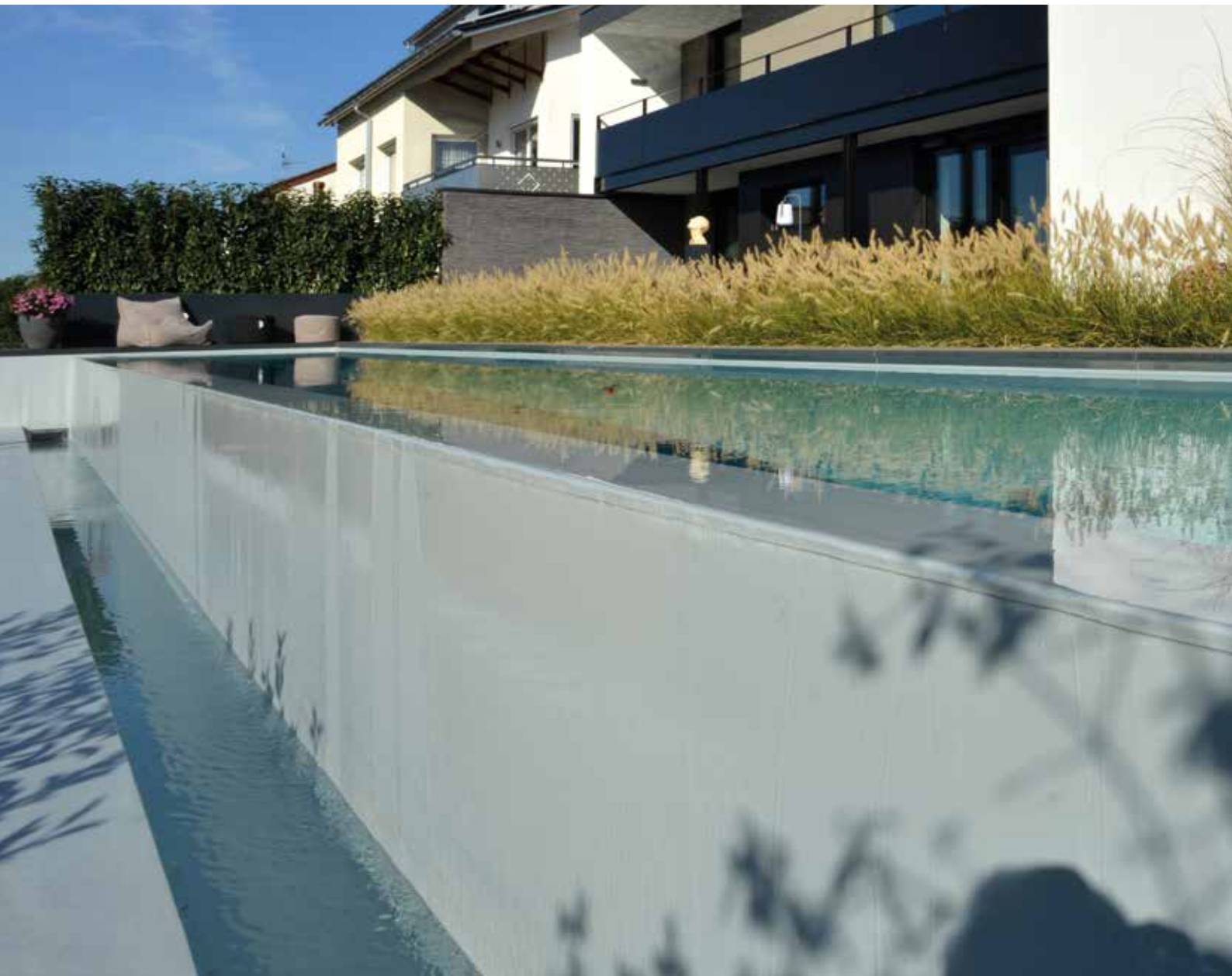
Aan de dalzijde is een infinity-goot aangelegd en het water loopt over de rand in de onderliggende goot. In combinatie met de instroomjets in de lange wanden wordt hierdoor een goede doorstroming bereikt.
