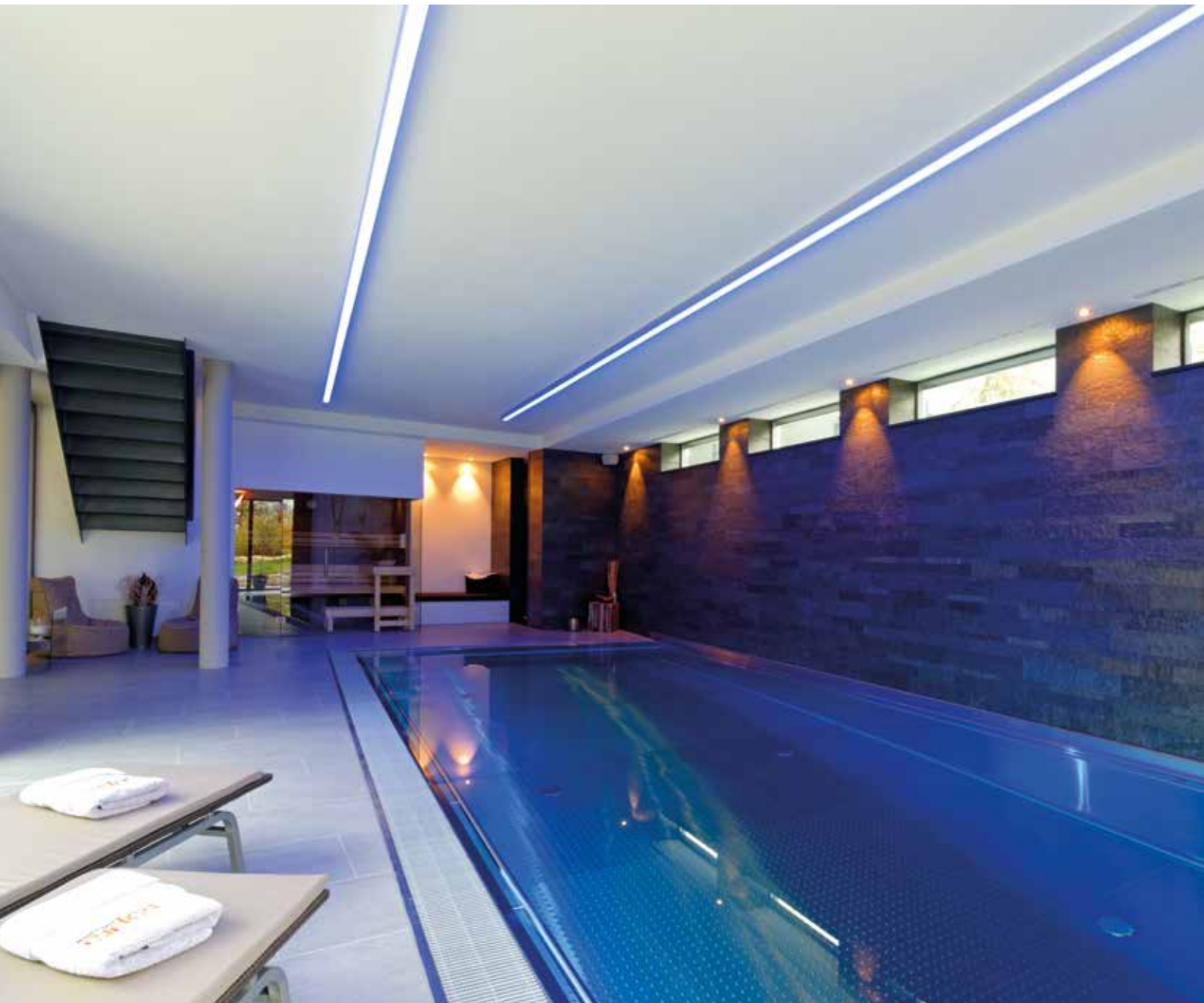
Het rvs-bassin is pal tegen de met natuursteen beklede muur geplaatst. Aan drie zijden is het bassin omgeven door een overloopgoot.
