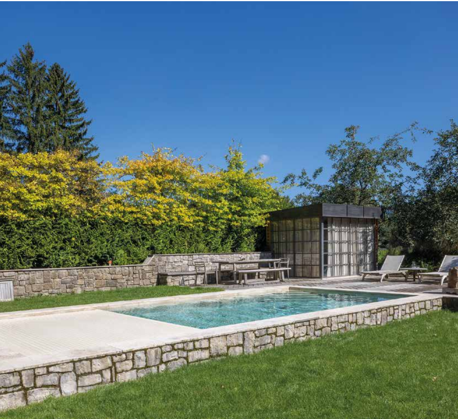
In een klein, nieuw gebouwd tuinhuisje direct naast het zwembad is de sopra-zwembadtechniek netjes en onderhoudsvriendelijk geïnstalleerd.
