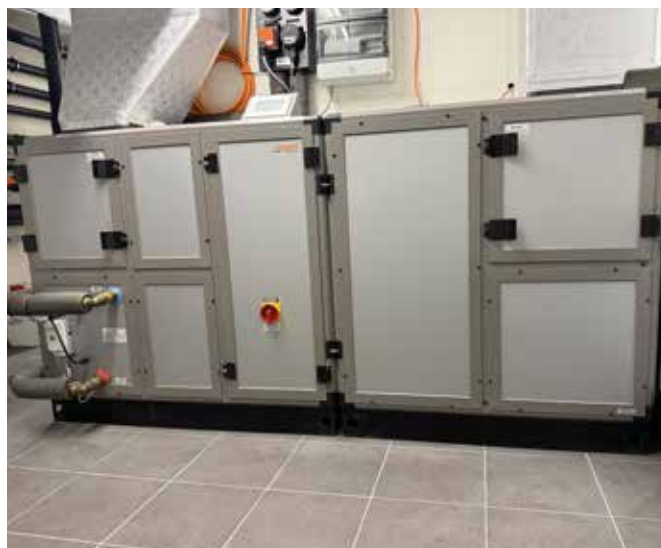
De sopra-zwembadtechniek in de kelder met "sopra test premium 17" en "soprazon premium 19" (links), het sopra-filtersysteem (boven) en het ventilatie- en ontvochtigingsapparaat.
